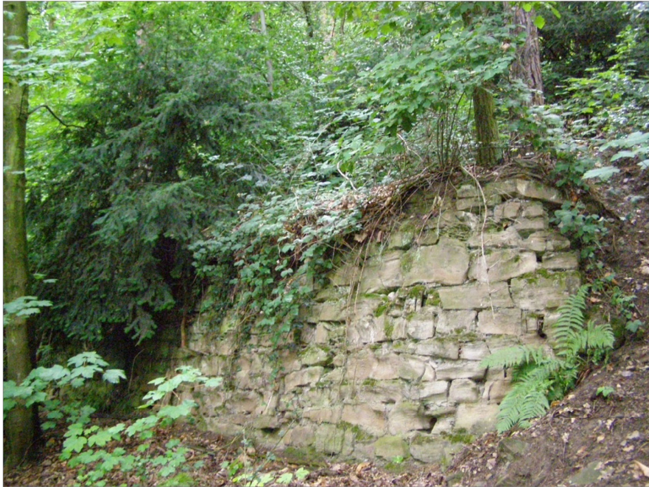
Abb. 4: Alte Steinmauer einer ehemaligen Weinbergterrasse im Untersuchungsgebiet; in diesem Fall aus Buntsandstein.
