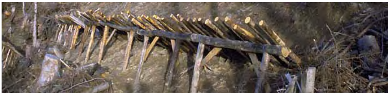
Abbildungen 3a/b: Typische Rundholzanwendungen: Einrichtungen für Kinderspielplätze (oben, Foto: Federlegno Ticino) und Holzrechen für temporären Lawinverbau (unten, Foto: C.Angst, www.waldwissen.net )
